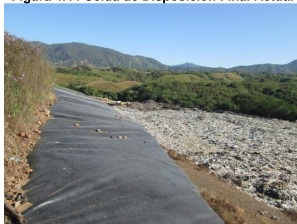
Figura 4.44 Celda de Disposición Final Actual
