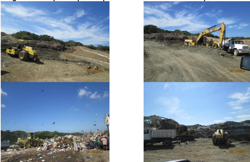
Figura 4.36 Maquinaria para Ampliación de Infraestructura de Disposición Final
