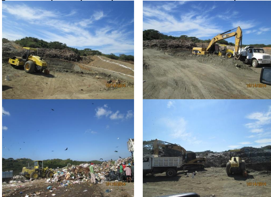
Figura 4.18 Maquinaria para Ampliación de Infraestructura de Disposición Final
