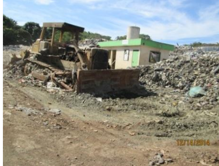
Figura 4.35 Maquinaria para operación del Sitio de Disposición Final
