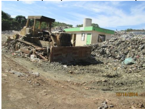
Figura 4.46 Maquinaria para operación del Sitio de Disposición Final
