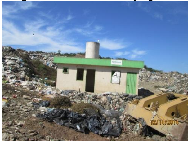
Figura 4.41 Caseta de Acceso y Vigilancia
