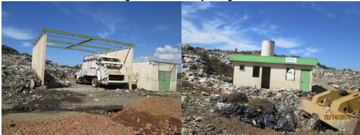
Figura 4.42 Cobertizo y Bodega
