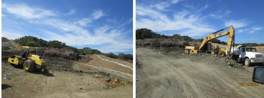
Figura 4.47 Maquinaria para ampliación de infraestructura del Sitio de Disposición Final
